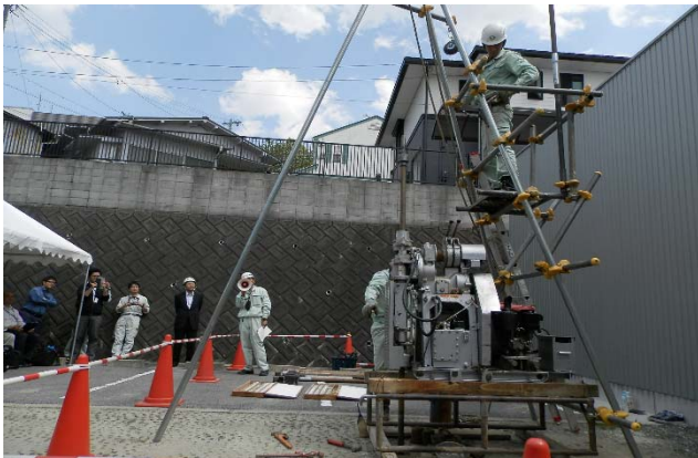
(ボーリング作業の解説状況)
